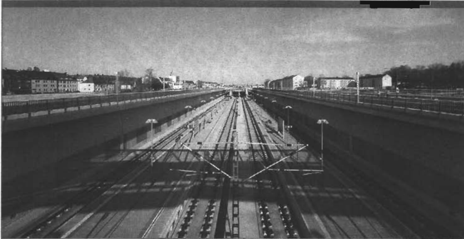
BILD 4: Blick in Trogbereich des Bahnhofs Neu-Ulm
