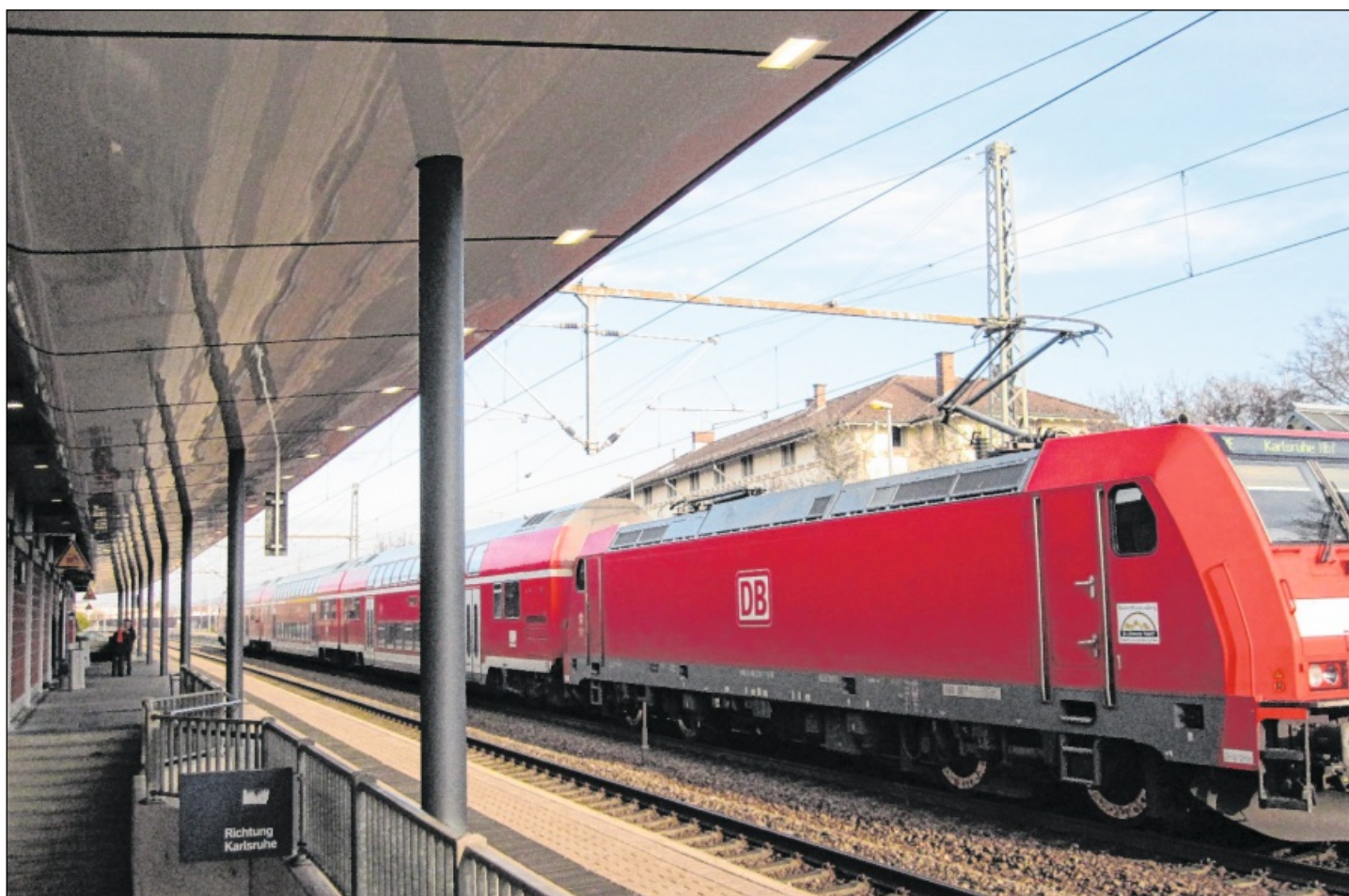
ELEGANTER SCHWUNG: Das neue Bahnsteigdach bietet Schutz vor der Witterung und setzt einen optischen Akzent. Es ist hell, luftig und nimmt die leichte Krümmung der Bahnsteigkante auf.
