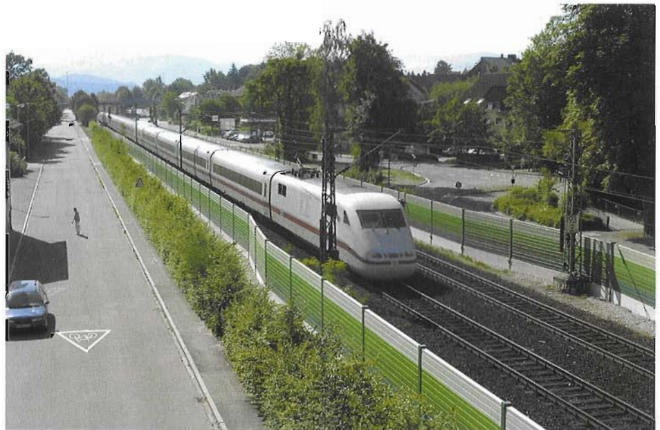
Bild 2: Lärmschutzwand Emmendingen mit Stahlpfosten und Aluminiumwandelementen
