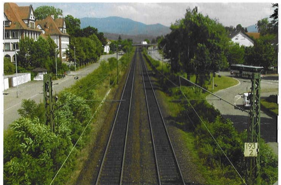
Bild 1: Durchfahrung der Stadt Emmendingen vor Erstellung der Lärmschutzwand
