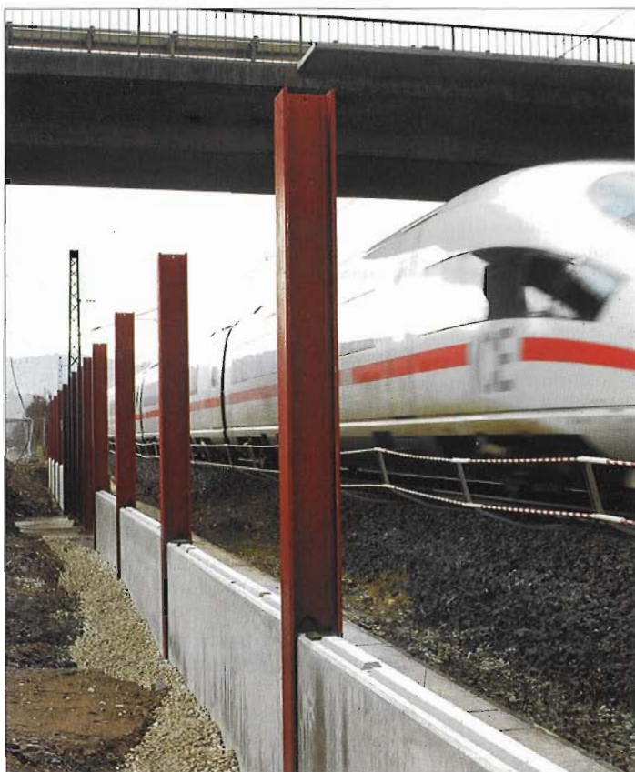
Bild 5: Bauzustand der Lärmschutzwand mit Sockelelementen und Stützen
